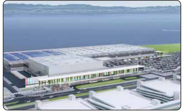
愛知県国際展示場の建設（空港島）
