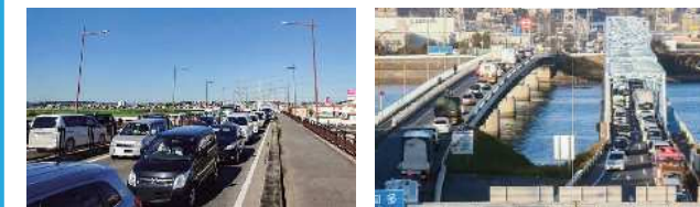
主要地方道知立東浦線(平成大橋)
