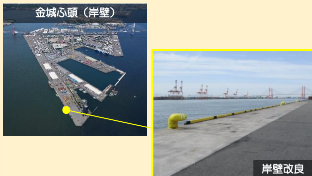
岸壁の老朽化対策
