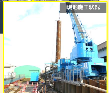
防潮壁の防災機能強化
