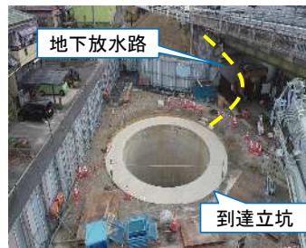
大規模特定河川事業 日光川2号放水路
